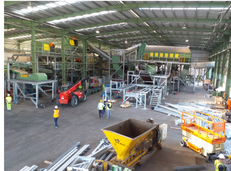
Instalación de equipos líneas de Tratamiento de RSU-EELL
