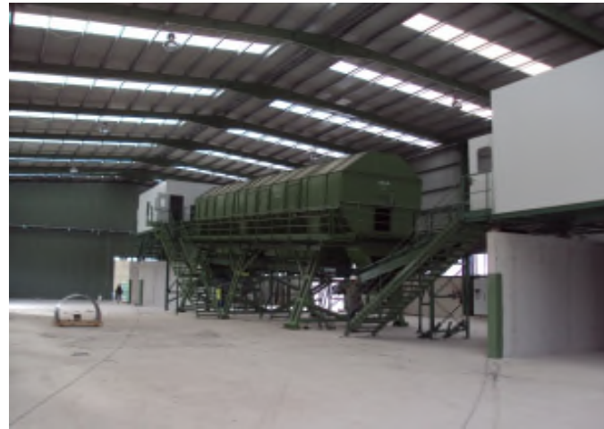
Cabina Primaria, Trómel de Cribado y Cabina Secundaria
