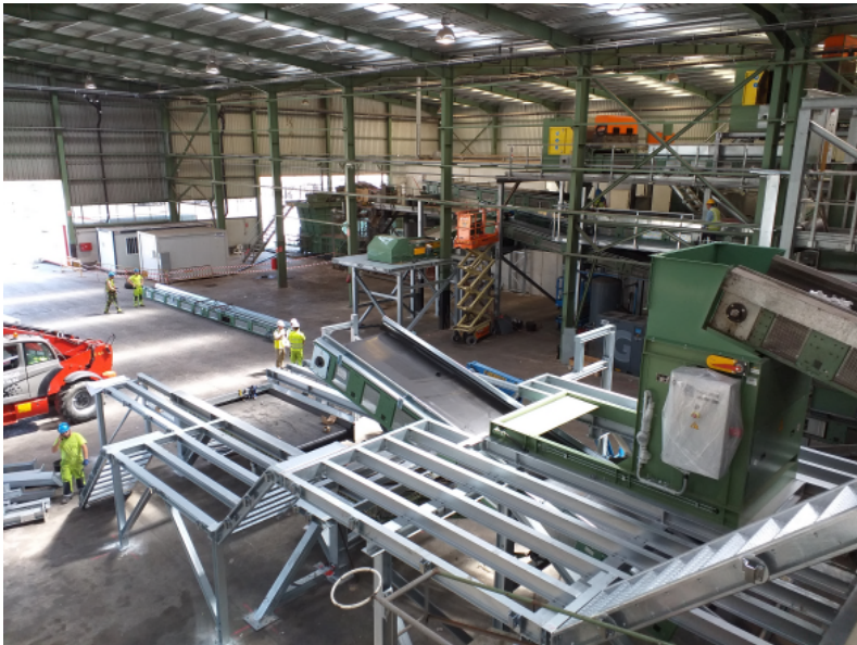
Instalación de equipos líneas de Tratamiento de RSU-EELL
