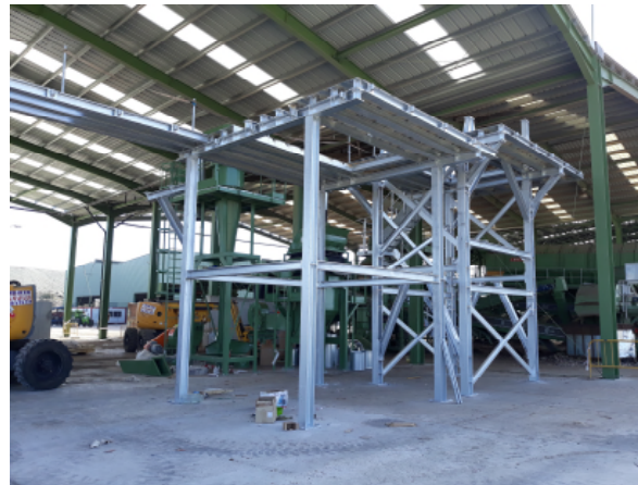
Vista de los trabajos de Instalación de Maquinaria
