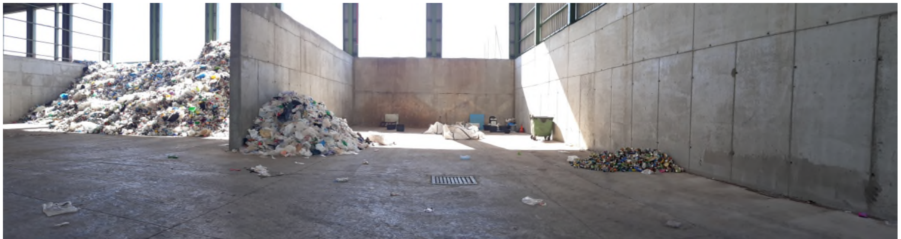
Vista del Interior de la Nave Terminada. Incluyendo Foso para Almacenar Envases Ligeros y Foso para Almacenar materia Orgánica Recogida en Origen
