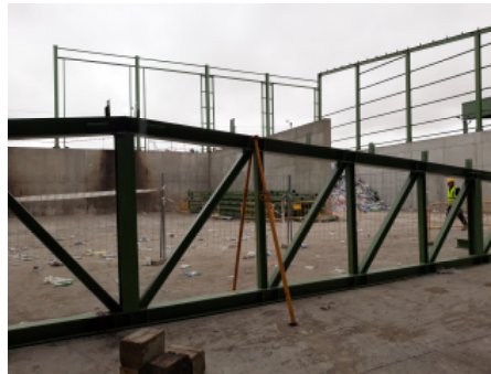
Cercha de Nave de Alimentación
