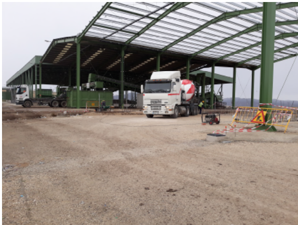
Vista de la Nave durante los trabajos de Ejecución
