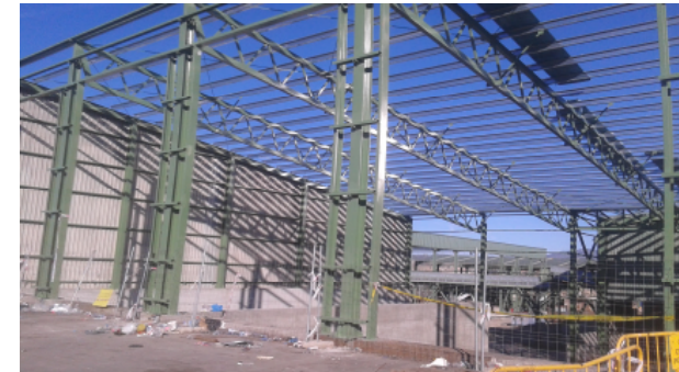
Vista de la Nave durante los trabajos de Ejecución
