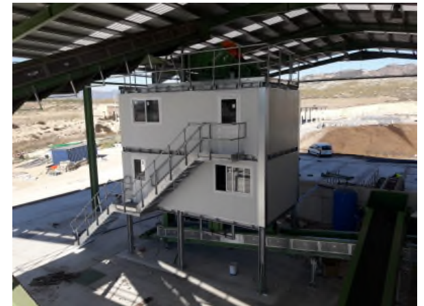
Vista de los trabajos de Instalación de Maquinaria
