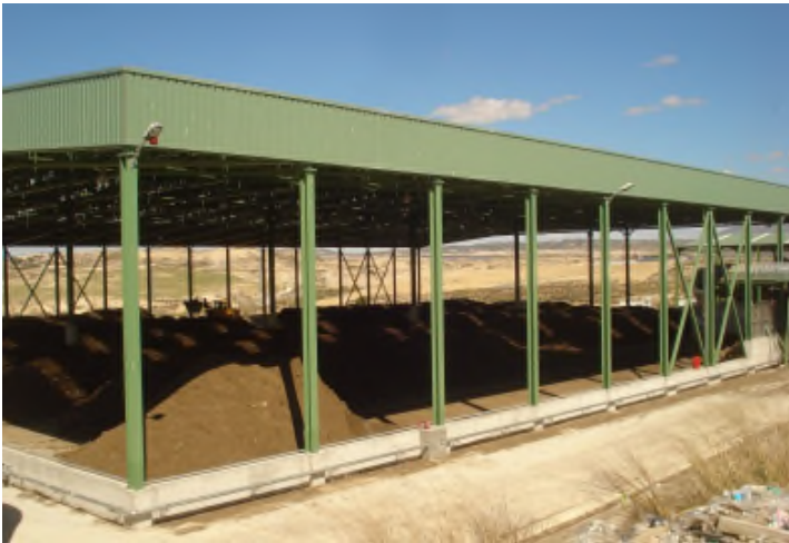
Nave de Maduración-Fermentación de Compost
