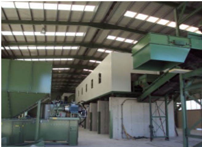
Cabina Secundaria y Prensa de Materiales
